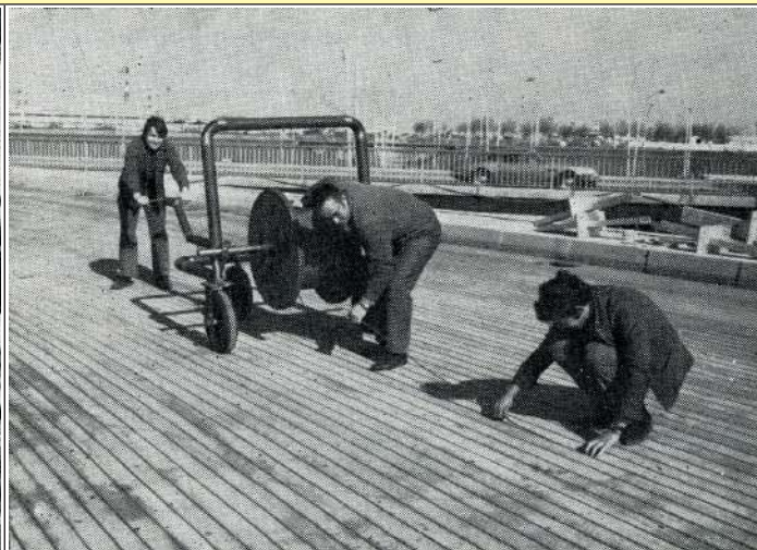
1968 Instalación de la malla calefactora en una rampa de acceso a una plataforma de estacionamiento de autobuses, aeropuerto de Orly cerca de París (Calefacción eléctrica del suelo, por Robert Félix, 1971, Museo Ultimheat*)
