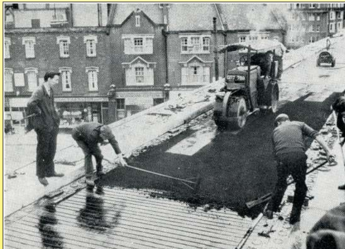
1969 Colocación de asfalto en la calzada superior de un cruce Hammerschmidt en Londres (Calefacción eléctrica de las carreteras, por Robert Félix, 1971, Museo Ultimheat*)
